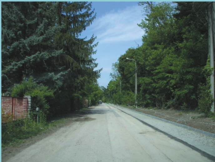
A kivitelezés befejeződött
