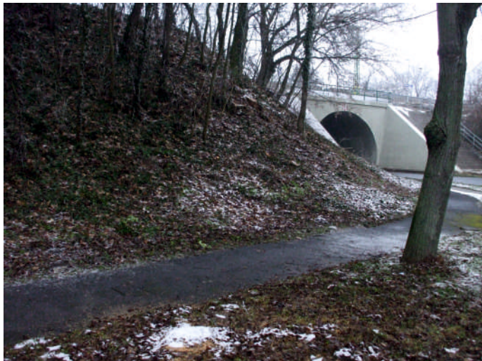
Aligai vasútállomás felhajtó kitisztítása
