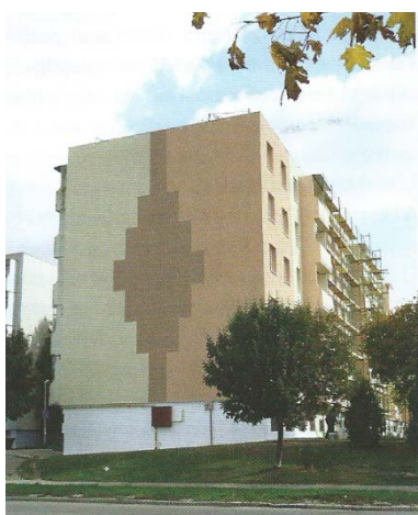
Homlokzat-felújítás, harmonikus színezés
