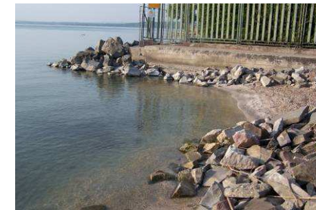
A község Balaton partján nem folyamatos a beton partvédő mű. Több helyen természetes szakaszok is találhatók
