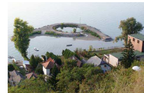
A vízmű használaton kívüli szivattyúállása
